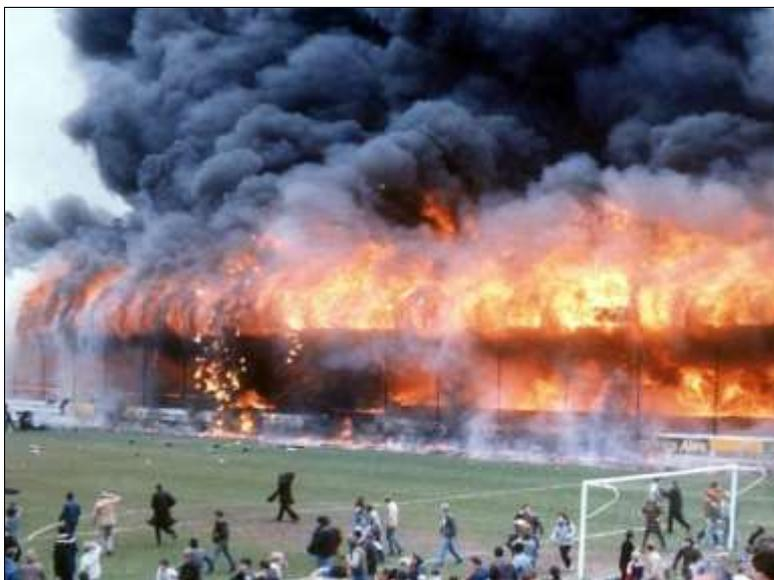
El 11 de mayo de 1985, 56 personas fallecieron en el estadio de Bradford, (Inglaterra). El fuego comenzó en las gradas de madera debido a un cigarro y se extendió rápidamente por la acumulación de papeles y basuras bajo las gradas de madera. El techo se derrumbó, con madera y asfalto cayendo sobre la multitud. Confundidos por el humo negro, los espectadores intentaron huir por rutas estrechas que conducían a puertas cerradas.
