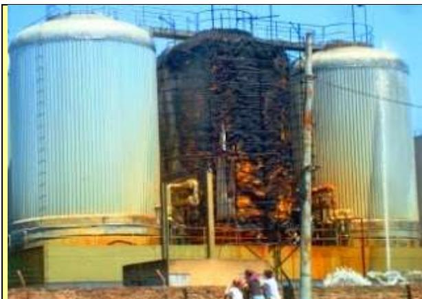
En 1913 un incendio afectó un tanque de fermentación de Cervecería Quilmes (Quilmes-Argentina). El fuego comenzó cuando un contratista generó chispas que inflamaron la aislación (poliespán) (poliestireno expandido) el agua de los bomberos sobre el tanque caliente provocó su deformación
