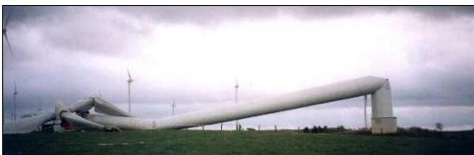
Las palas también están sujetas a rotura, especialmente por vibraciones y sobrevelocidad, que genera su desprendimiento, el desbalanceo del conjunto y posterior caída de la torre, como se muestra en el siniestro ocurrido en Vedadillo (Navarra).
