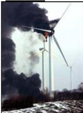
Los incendios pueden ser tanto por rayos como por sobrecalentamiento de cojinetes, fallas en el sistema de lubricación (un generador cuenta con 200 a 400 litros de aceite en su interior), corto circuitos, y especialmente por chispas durante los trabajos de mantenimiento.
